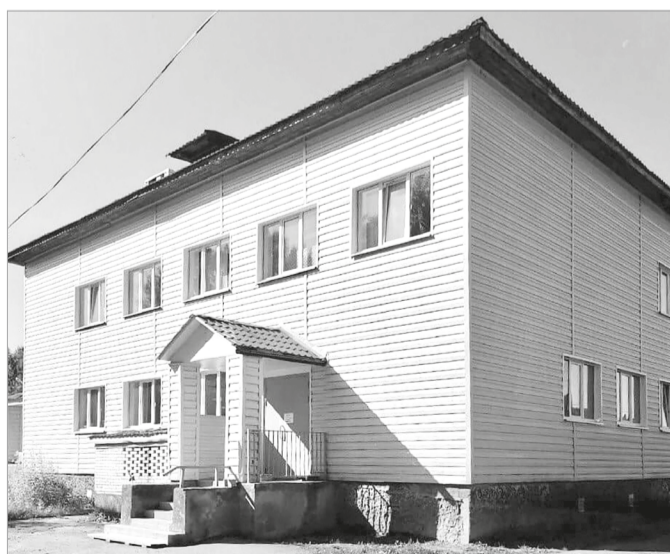
Алеховщинская врачебная амбулатория после ремонта
